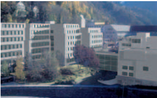
Mit Aussendämmung eingepackt (Bauengineering / Hubert Bischoff)
