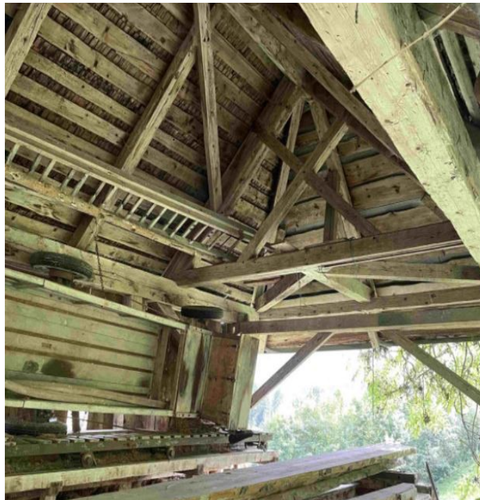
Abb. 7 Sägeraum, Blick Richtung Süden
