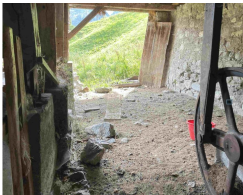
Abb. 5 Gemauertes Untergeschoss mit Transmissionsantrieb
