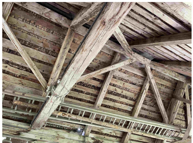
Sägeraum, Dachkonstruktion Foto DPG 2021
