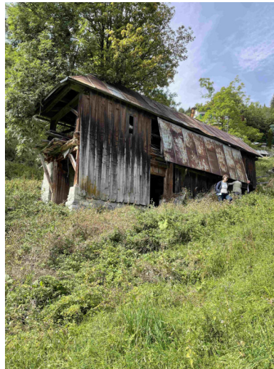
Ansicht von Südosten. Das heruntergeklappte Blechdach schützte einst das Wasserrad. Foto DPG 2021
