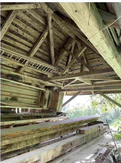
Sägeraum Blick Richtung Süden Foto DPG 2021
