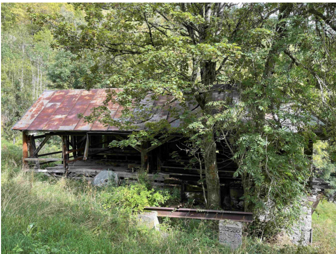
Ansicht von Westen Foto DPG 2021
