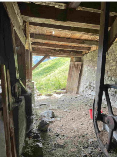
Gemauertes Untergeschoss, Blick Richtung Süden Foto DPG 2021
