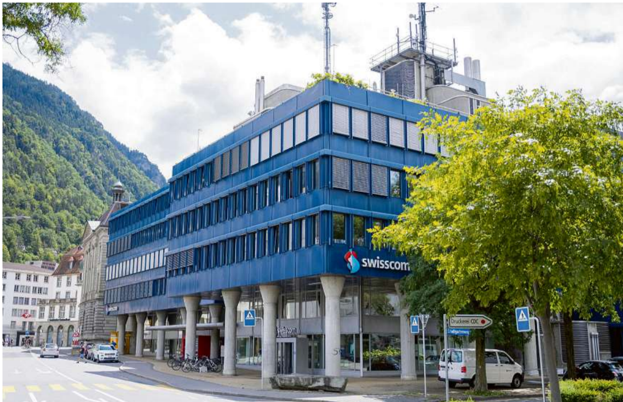
Zeuge der Zeit: Fachleute wehren sich gegen die Umgestaltung der Fassade am Swisscom-Gebäude in Chur.
