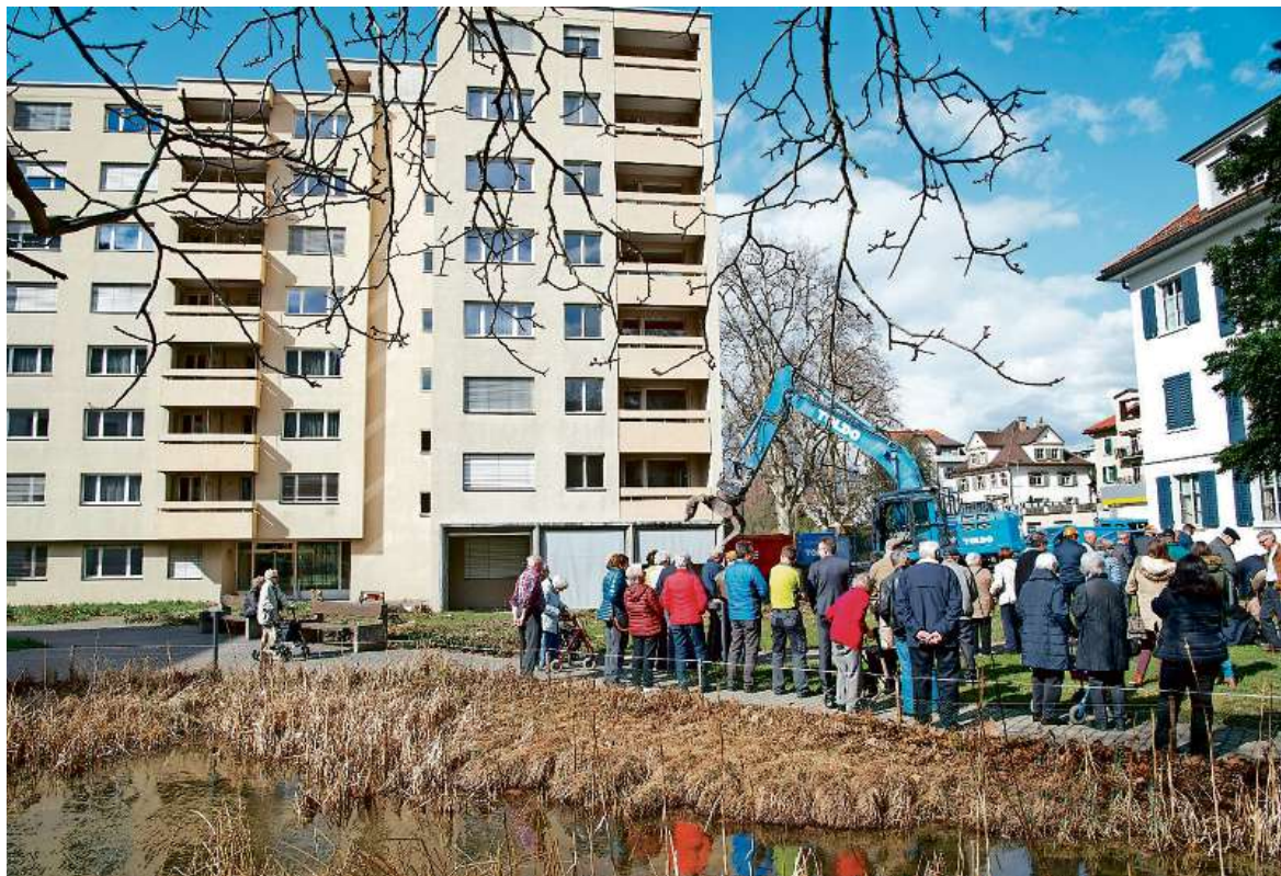
Bereit für etwas Neues: Beim Spatenstich für den Neubau im Seniorenzentrum Rigahaus in Chur beobachten die Bewohner, wie die erste Baggermaschine für die Abrissarbeiten auf das Gelände fährt. (FOTO MARCO HARTMANN)
