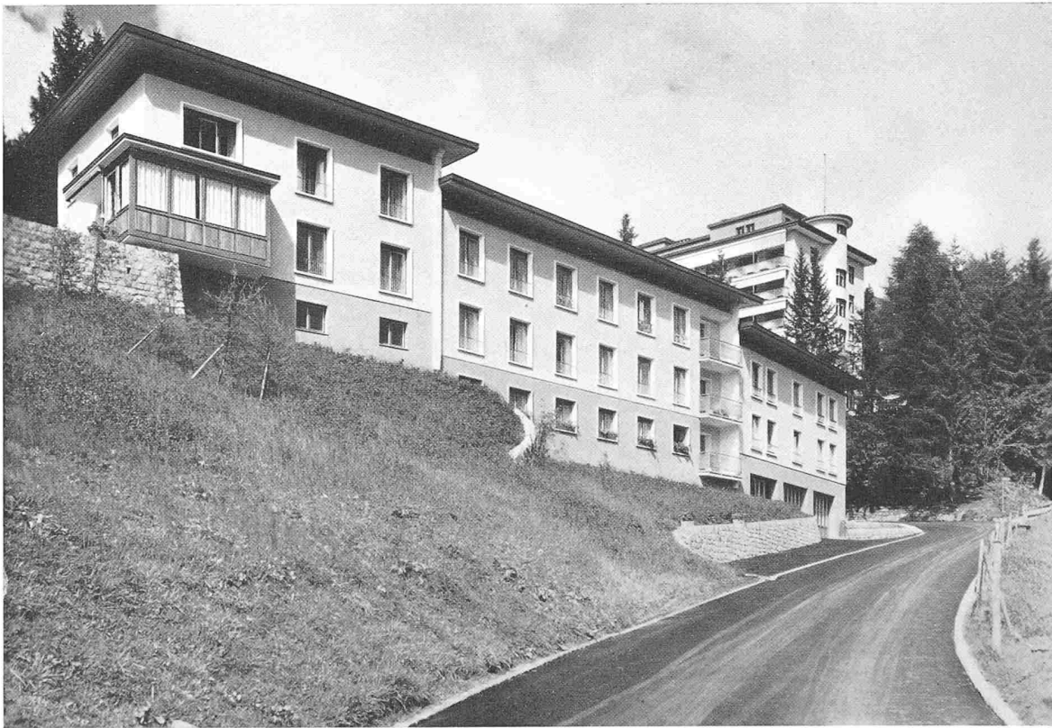
Ansicht des Personalhauses aus Süden
