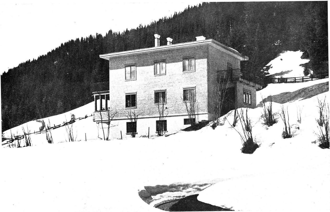
Ansicht aus Nordosten
