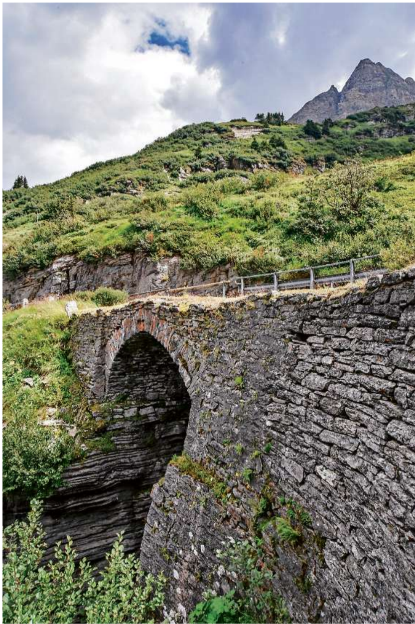
Einst Teil der Passstrasse: Geht es nach den Plänen des Tiefbauamts, wird die alte Brücke Casott am San Bernardino für immer verschwinden.
