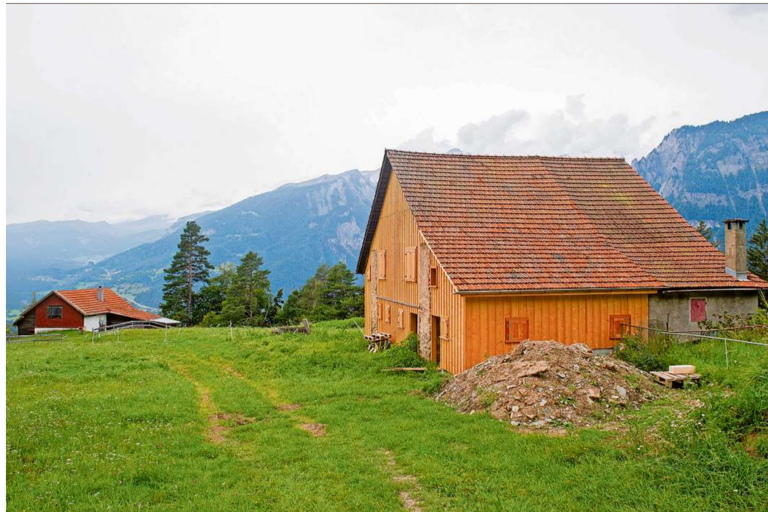
Zu luxuriös: Bei diesem ursprünglich alten Stall auf den Emser Maiensässen muss so einiges zurückgebaut werden.
