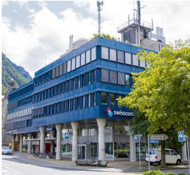
Die Blaue Post in Chur: Entscheidend für den unverwechselbaren Charakter des markanten Gebäudes sind die blauen Blechfassaden und der von mächtigen Betonsäulen gesäumte, zweigeschossige Arkadengang. (FOTO MAYK WENDT)
