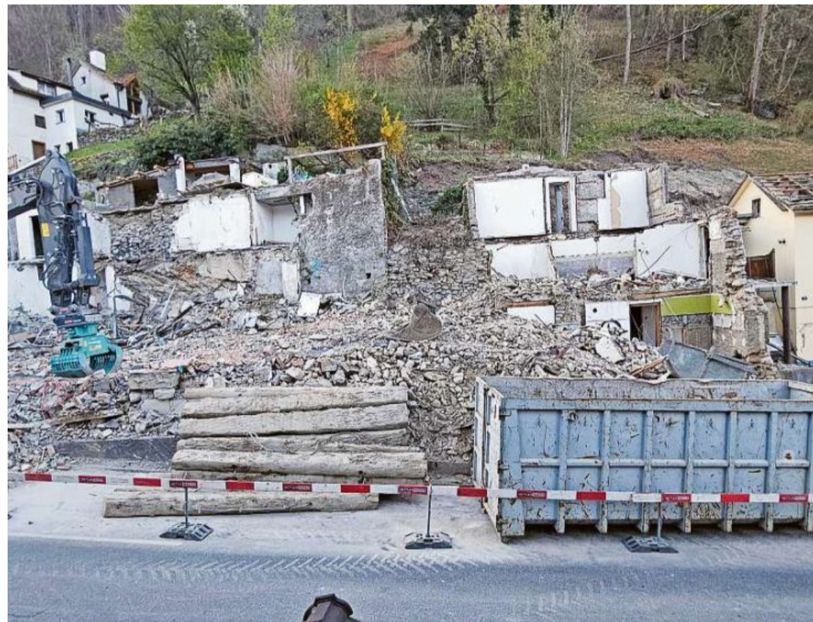
Abbrüche an der Lürliadstrasse in Chur. (FOTO ZVG)
