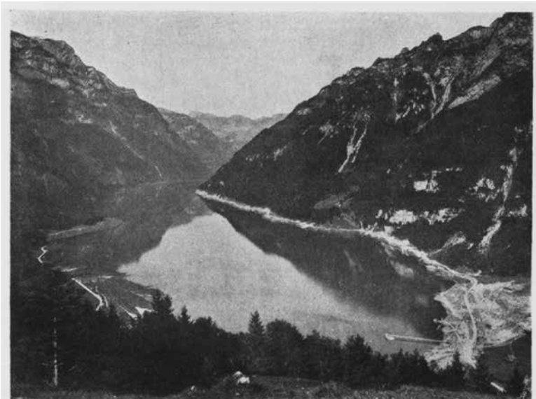
Abb. 16. Der Klöntalersee, wie er ist (gestaut). Seeufer entschieden malerischer geworden. Schutthalde rechts aus der Bauperiode. Cliché der Schweiz. Bauzeitung, Zürich. – Fig. 16. Le lac du Klöntal, aujourd'hui. Les rives sont certainement plus pittoresques. L'éboulis à droite date de l'époque de la construction
