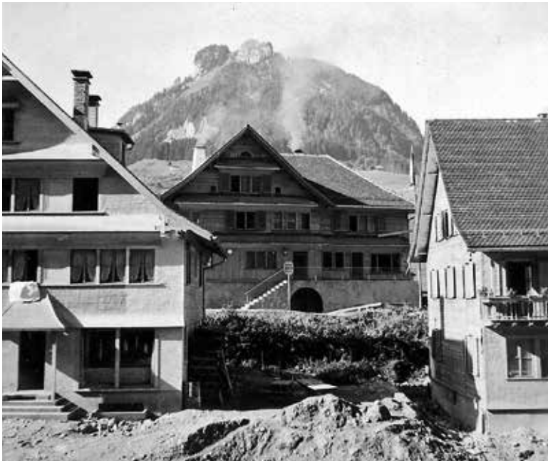
Wiederaufbau von Stein SG unter der Leitung von Max Kopp, 1947–51, Aufnahme kurz vor Fertigstellung (gta, 54, Nachlass Max Kopp, Schachtel «Stein Togg.»).
