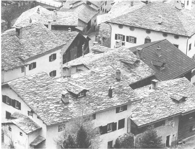
Einheitliche Steinplattenbedachung im Ortskern Splügen auf der Basis der Steinplattendachverordnung.
