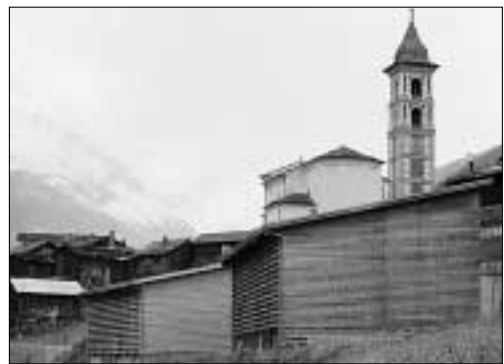
Neue Bauten in das Ortsbild integriert: Ställe und Kirche im Vriner Dorfkern. (Ky)
