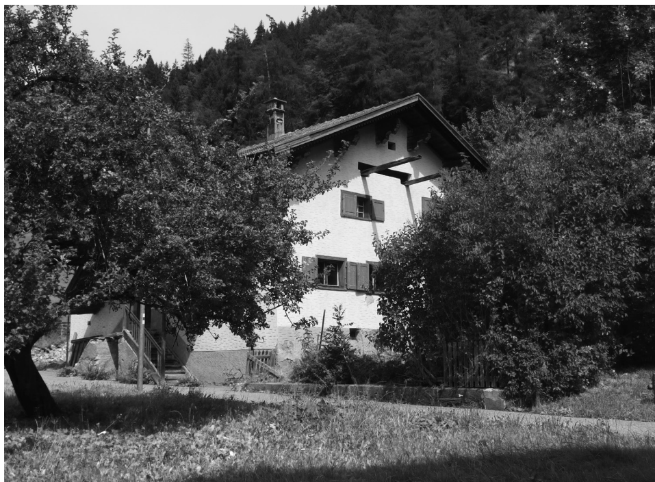
Weitgehend authentisch erhaltene Bauernhausanlage aus der Zeit um 1820 am nördlichen Dorfausgang von Obersays. Die Stallscheune ist bereits zerstört, der Wohntrakt dem Abbruch geweiht (© Michael Hemmi, Trimmis).
